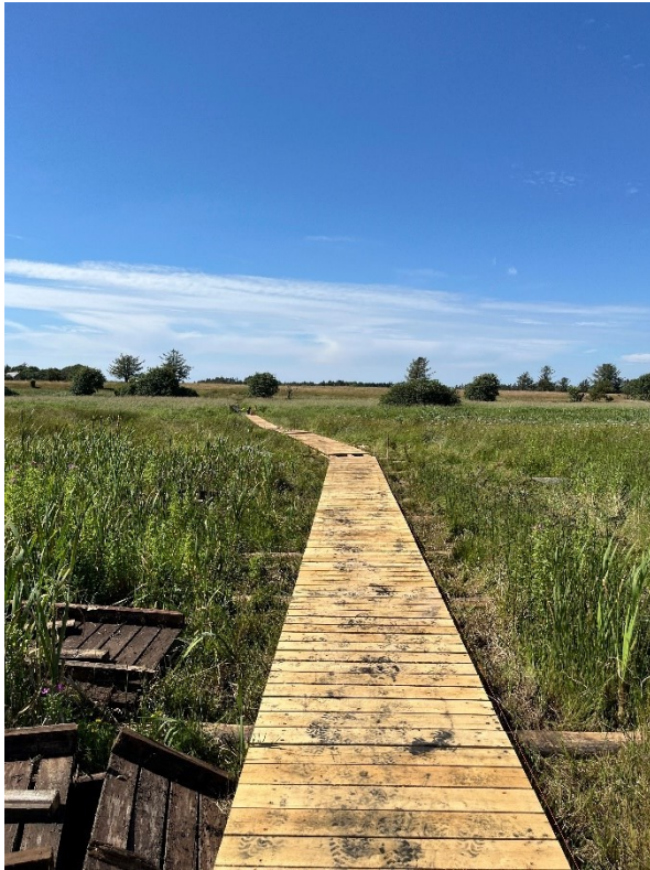
Figur 5: eksempel på boardwalk med træoverflade. Foto: Lasse Filsø, Thisted Kommune
